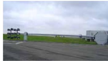
De 2004 à 2010, pour les aires de dégivrage de RCG, Petitjean a livré 10 mâts basculants de 19 mètres à vérin hydraulique. Pour des raisons de sécurité, ils restent en position horizontale, donc abaissés, lorsque les aires ne sont pas utilisées, un cache de protection ayant spécialement été étudié pour protéger le point de basculement de ce positionnement.
