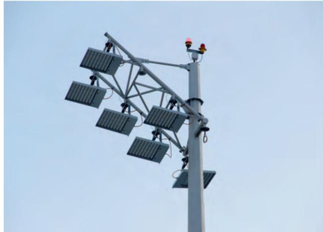
Der LED-Flächenstrahler F32 wird an der bestehenden Halterung angebunden.
